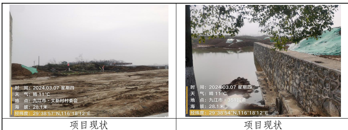
图1-1 现场施工情况
